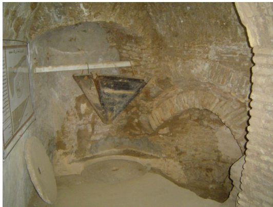
تصویر ۱۳. سنگ آسیاب مستقرشده روی چاله قرارگیری توربین. در تصویر چاله جمع شدن آرد در کنار سنگ مشخص است (مأخذ: نگارندگان).
